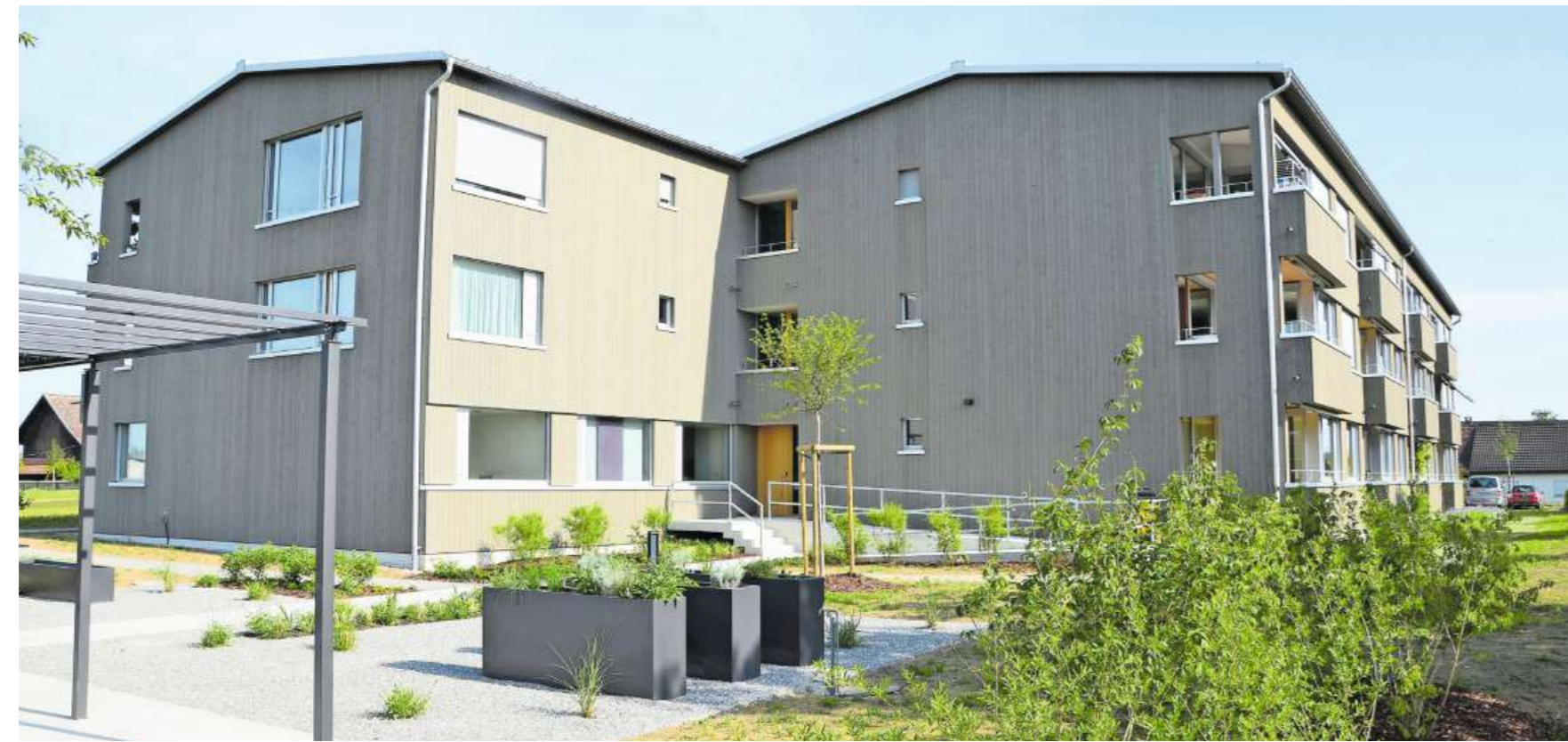
Die gegeneinander verschobenen Baukörper bilden ein einziges Haus, welches sich harmonisch in das Dorfbild einfügt.
